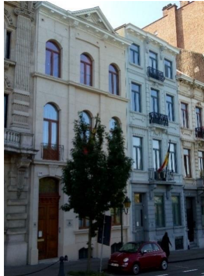
Na oprissingswerken van de voorgevel
